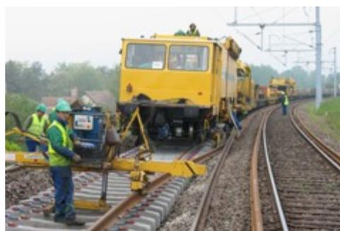
*Longs Rails soudés sur traverses béton*
